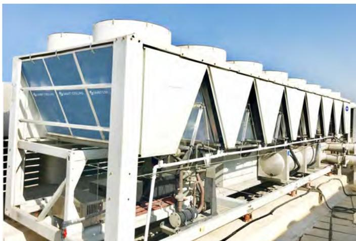
'Smart Cooling <sup>TM</sup>' en action. Avec un système intelligent de pré-refroidissement adiabatique, les refroidisseurs peuvent fonctionner même dans des conditions extrêmes, offrant un rendement élevé avec une consommation d'eau minimale.
