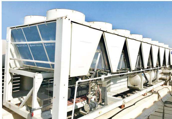
Система “Smart Cooling™” в действии. Благодаря интел-лектуальной адиабатической системе предварительного охлаждения, охладители могут работать даже в экстремальных условиях, обеспечивая высокую производительность при минимальном расходе воды.
